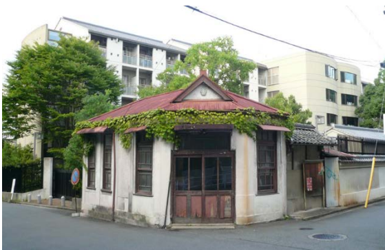
写真 2 旧鍋屋連絡所（改修前）
