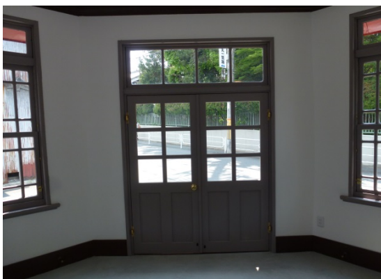
写真9 両開扉に改修された正面入口
